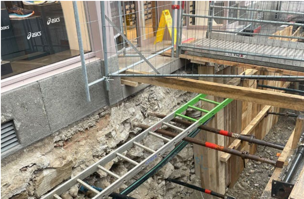
Anspruchsvolle Baugrubenarbeit entlang den Häuserfassaden in der Badstrasse (Bild: Stadt Baden)
