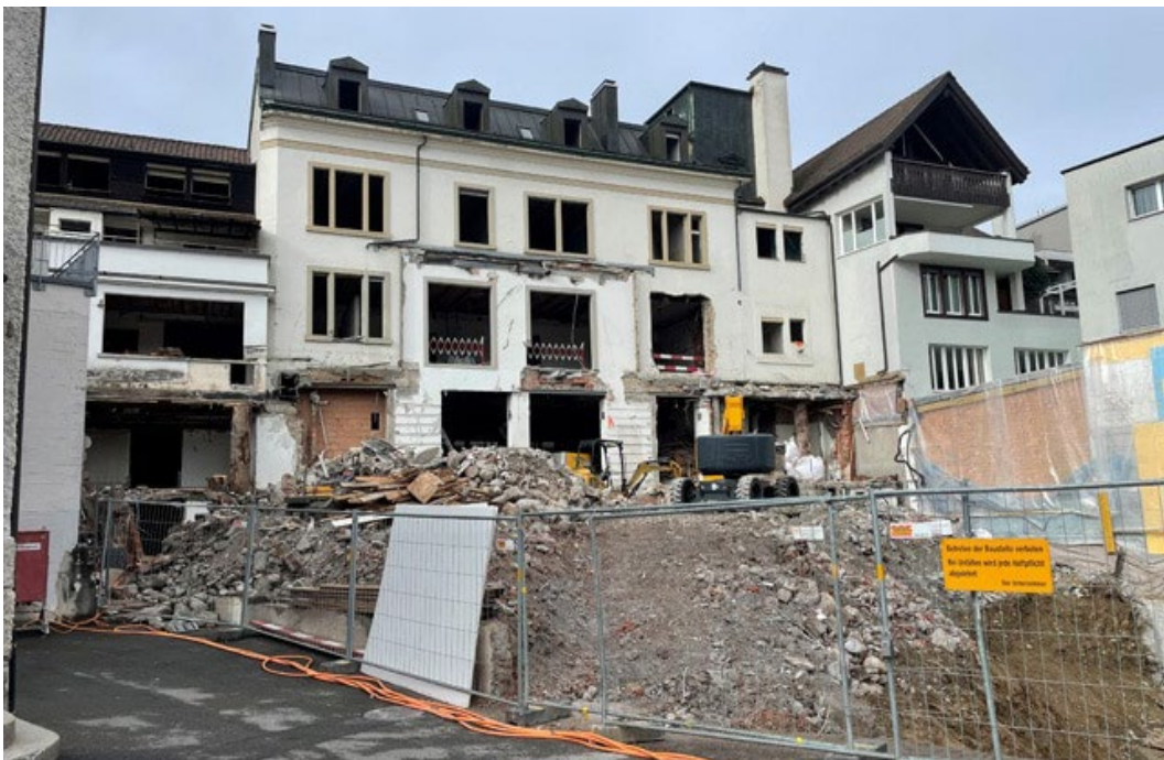
Der erste Teil der Gebäude an der Badstrasse 28/30 ist abgebrochen (Bild: Stadt Baden)
