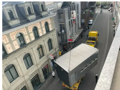
Sichere Landung: Eines der beiden Stahl-Elemente wird auf dem Transporter der Firma Hächler abgeladen.
