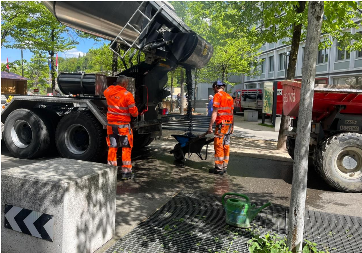
Auf dem Installationsplatz wird der Belag vorbereitet. Bild: Anja Harnisch
